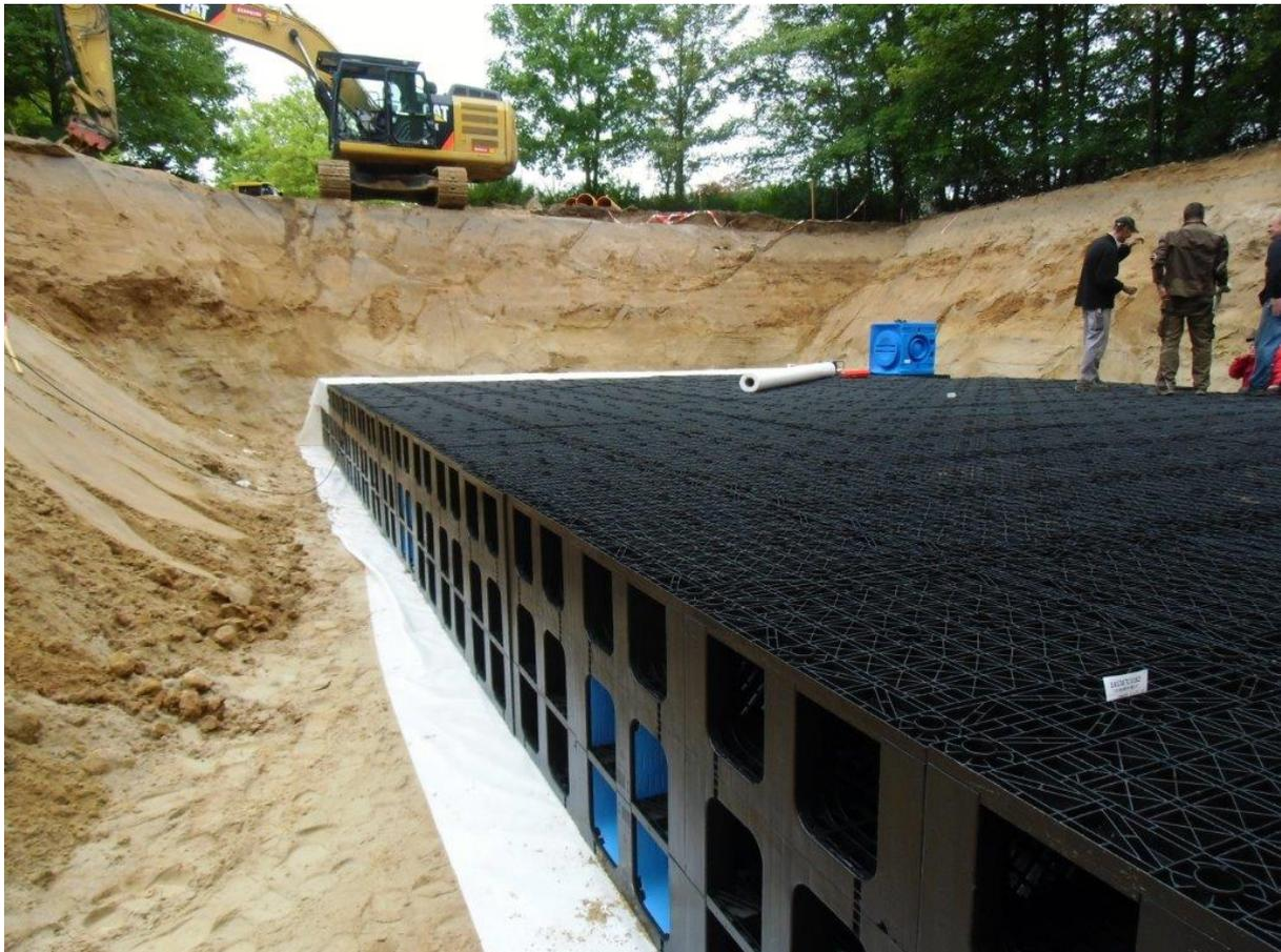
Die Rigolen sind mit Sedimentationsstrecken ausgerüstet, sodass eine Verschmutzung der Versickerungsbauwerke vermieden wird. Die Bauwerke werden zunächst 4 x jährlich gewartet (Spülen und saugen).
